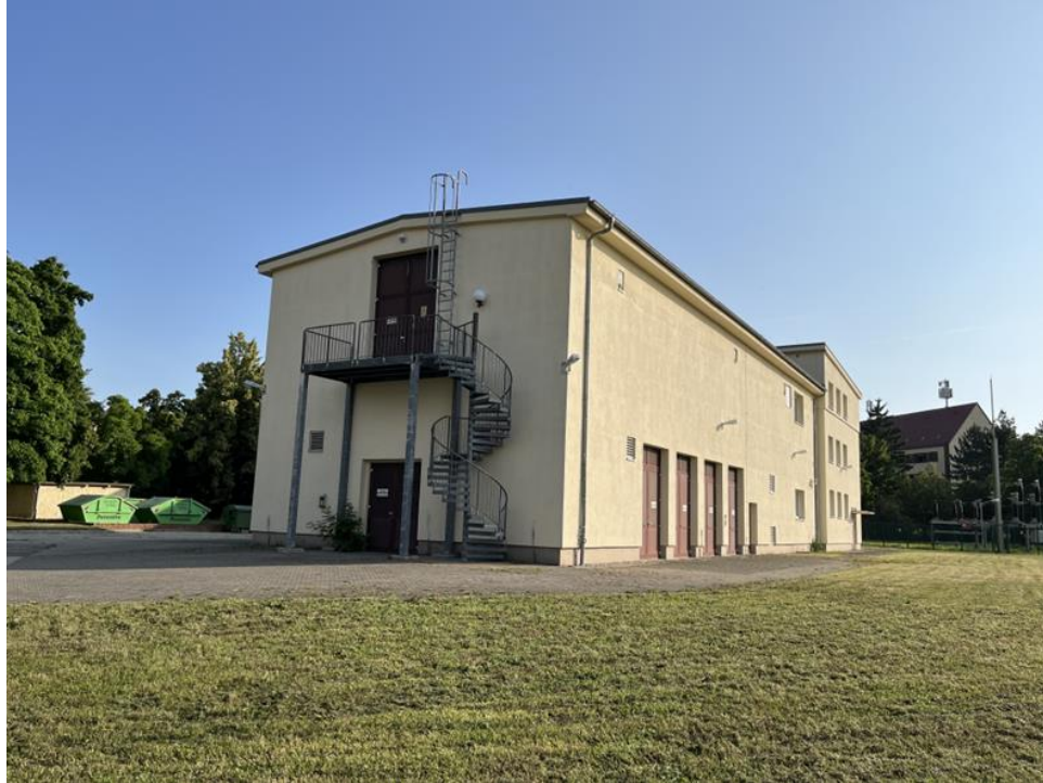
Beispiel Umspannwerk C - Werkstättenweg
